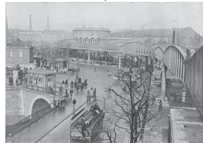
LE METROPOLITAIN DE PARIS : Section aérienne : la traversée du rond-point de la Villette
